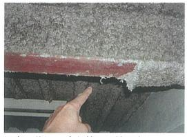
写真の状況:吹き放し工法であり、セメント スラリーもなく脱落箇所がある。
