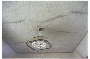
写真の状況:面的な状況はよいが、振動、乾 燥収縮などによる筋状の呼吸作用の痕が見ら れる。
