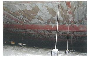
写真の状況:折板屋根において、気温や風圧 による折板屋根の収縮や振動での脱落が見ら れる。
